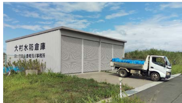
大村水防倉庫からの搬出状況
