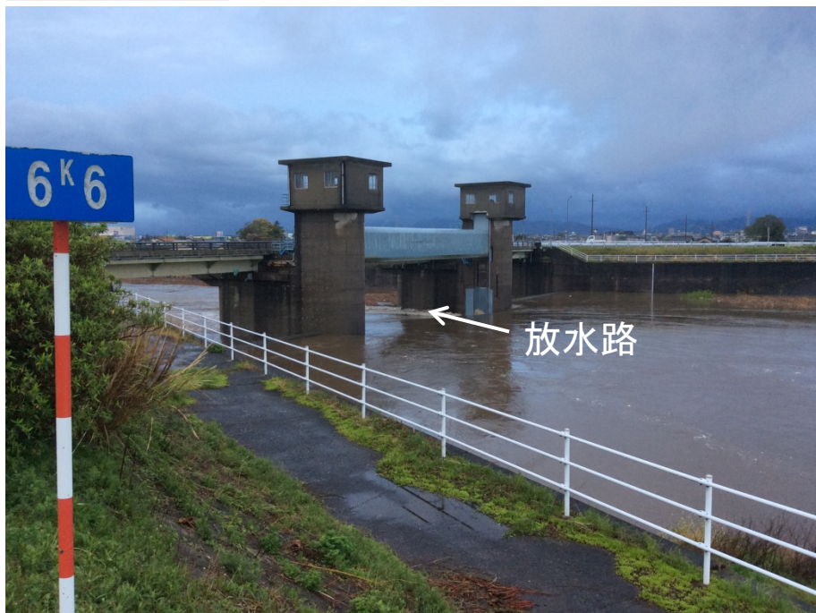
豊川放水路分派堰[豊川市行明](18日6:00頃)
