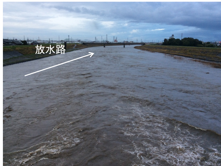
豊川放水路より下流への放流状況(18日6:00頃)
