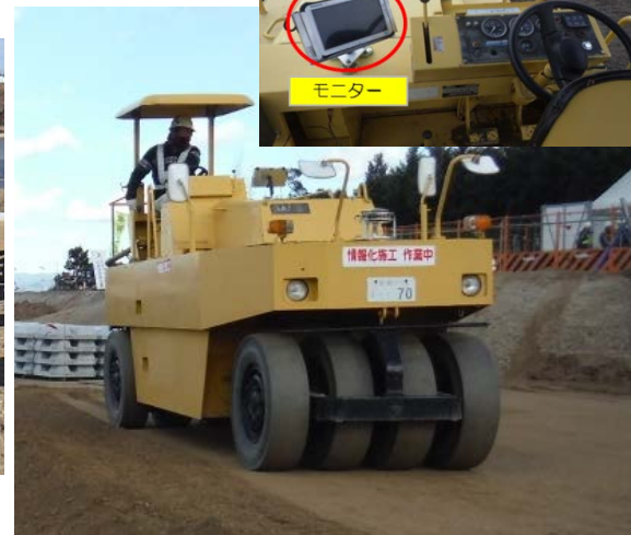
モニターで転圧回数を管理しながらローラーによる締め固め転圧
