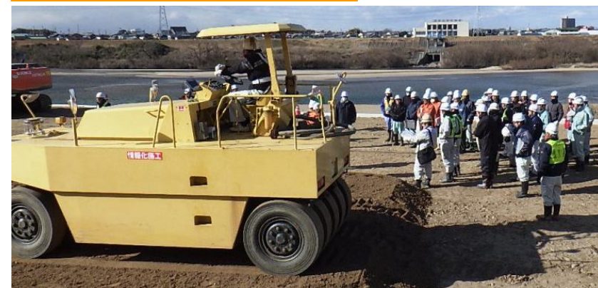
モニターで転圧回数を管理しながらローラーによる締め固め転圧
