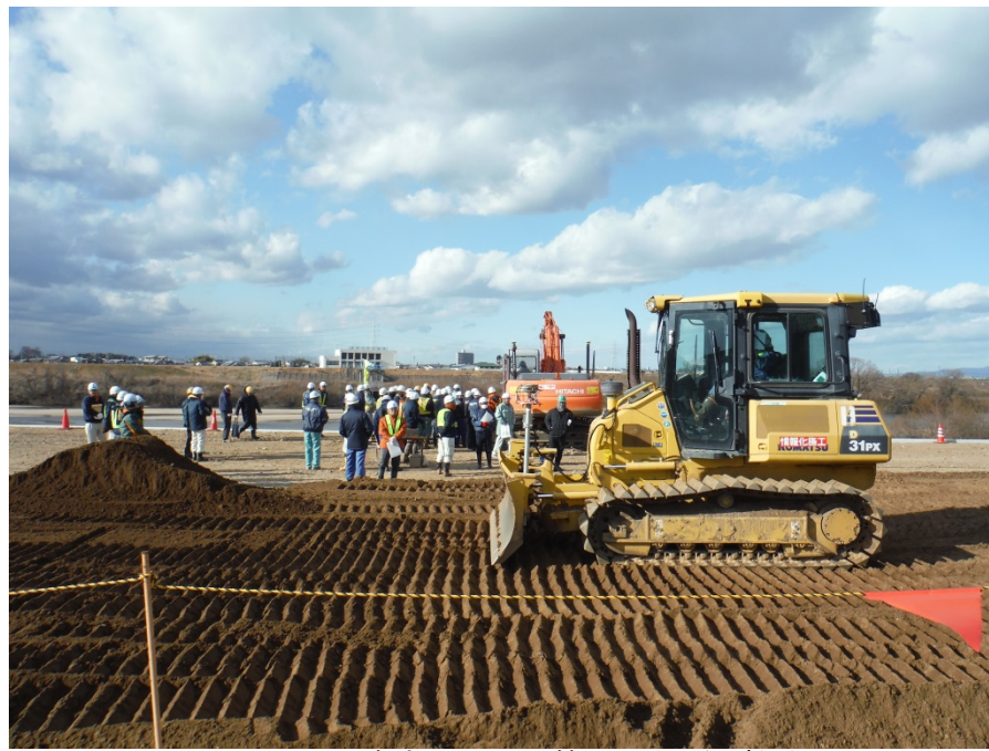
モニターで巻き出し厚を管理しながら敷均し
