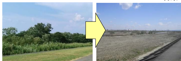
①左岸5.7k (西尾市田貫町) R2.3撮影
