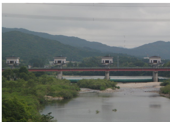
6月11日 堰下流より(約2.4m 3 /s) 牟呂松原頭首工
