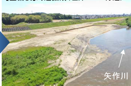
【整備後】河道掘削(左岸12.4k付近)
