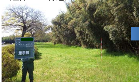
【整備前】樹木伐開(左岸40.8k付近)
