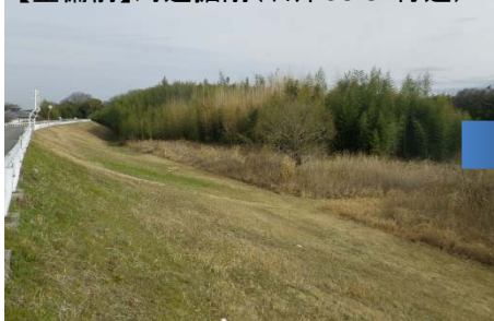
【整備前】河道掘削(右岸38.8k付近)
