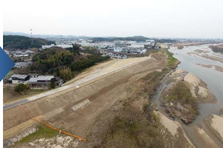
【整備後】築堤(左岸13.4k付近)
