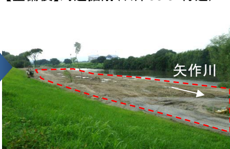
【整備後】河道掘削(右岸38.8k付近)
