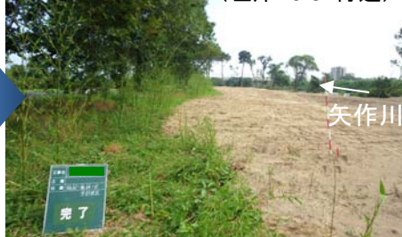
【整備後】樹木伐開(左岸40.8k付近)
