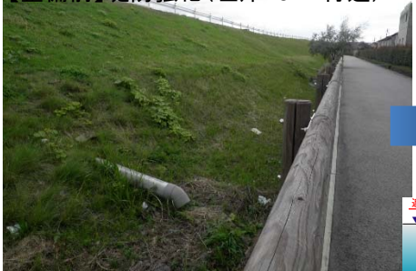
【整備前】堤防強化(左岸20.2k付近)
