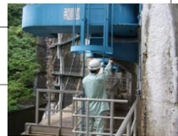
ゲートの点検
