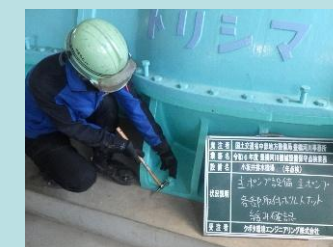
(ポンプ設備の点検・整備)
