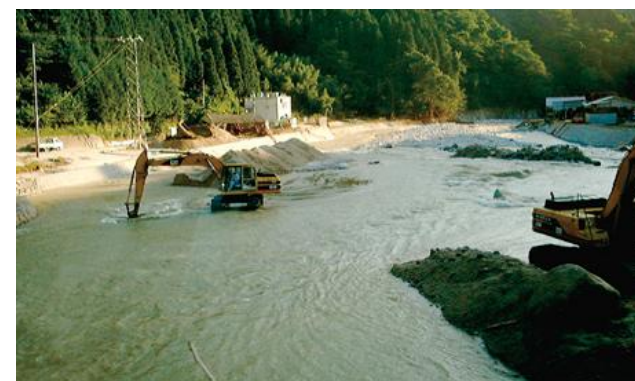
写真 矢作ダム貯水池に堆積した砂を掘削
