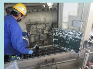
(エンジンの点検・整備)
