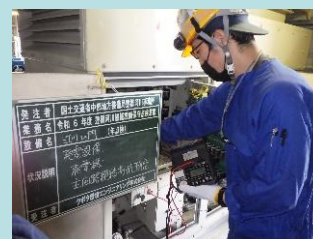
(機械設備の点検)
