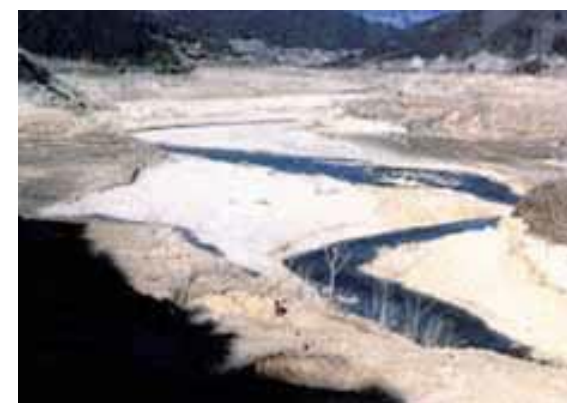
渇水被害の状況 矢作ダム貯水池(平成6年7月)
