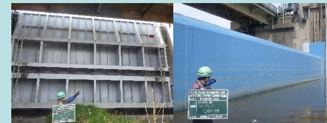
(ゲート設備の点検・整備)
