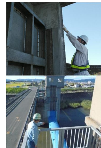
1次点検状況 (R2.9.27 豊川管内(震度4))
