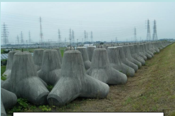
ブロックの状況(矢作川右岸7.4k付近)
