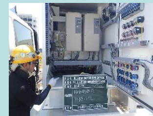
(操作設備の点検)
