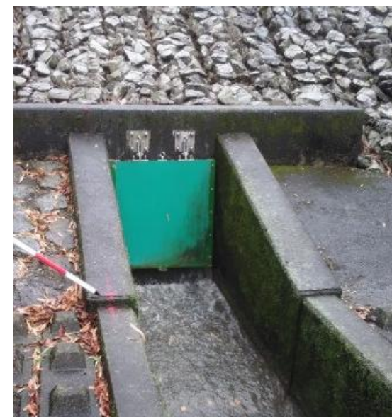
ゲートの無動力化(フラップ化) (矢作川 細川樋管)
