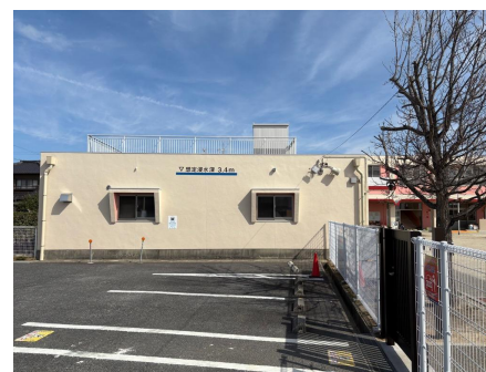
⑤公共施設に 想定浸水深表示を整備 (安城市)
