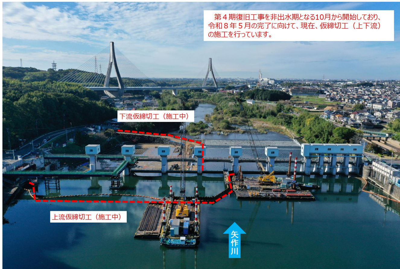
【明治用水頭首工全景（上流から）：令和7年11月6日(木)】
