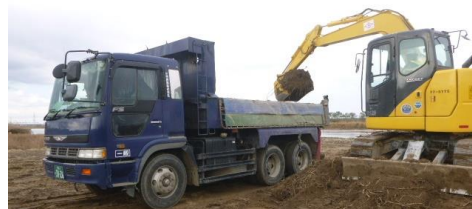
掘削土の干潟再生への利用
