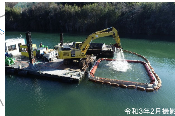
河道掘削(37.4k付近)
