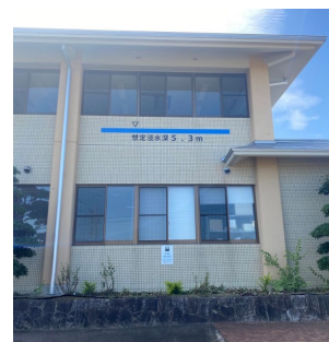
⑤公共施設に 想定浸水深表示を整備 （安城市）
