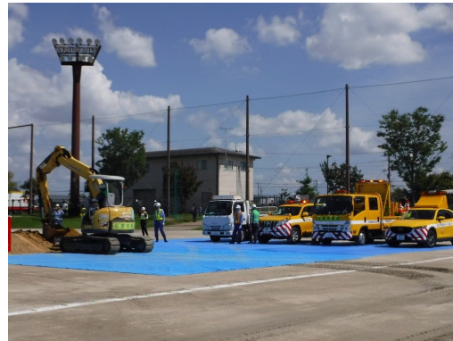
■道路啓開(名古屋国道事務所)
