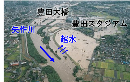
豊田市街地付近の越水氾濫状況
