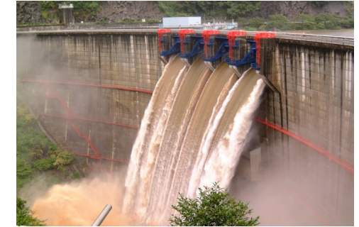
矢作ダム非常用洪水吐きからの放流 平成20年8月末豪雨
