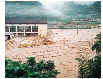
流失した幼稚園(豊田市(旧旭町))
