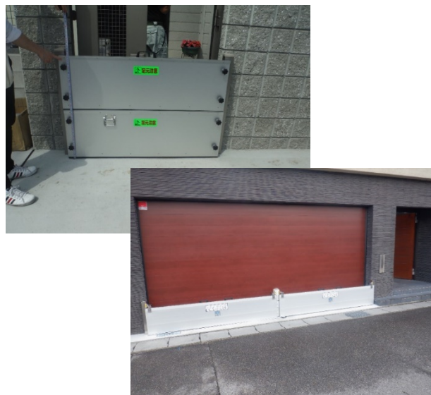
■止水板設置状況
