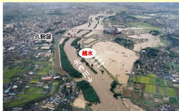
●平成12年9月「東海豪雨(恵南豪雨)」の被害状況(豊田市森地区)
