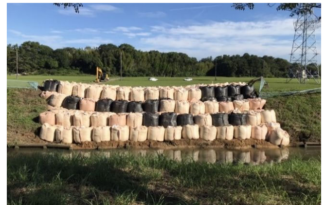
応急復旧完了 (7月28日AM7時20分)
