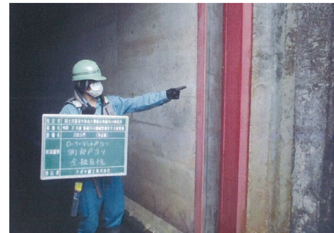
ゲート設備の点検
