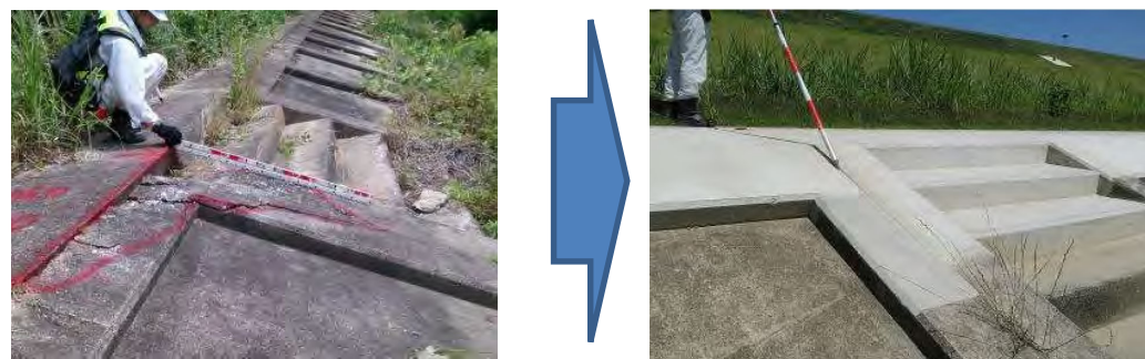
護岸の修繕(右岸16.0k付近)
