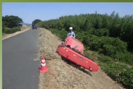
堤防点検のための除草で発生する刈草
