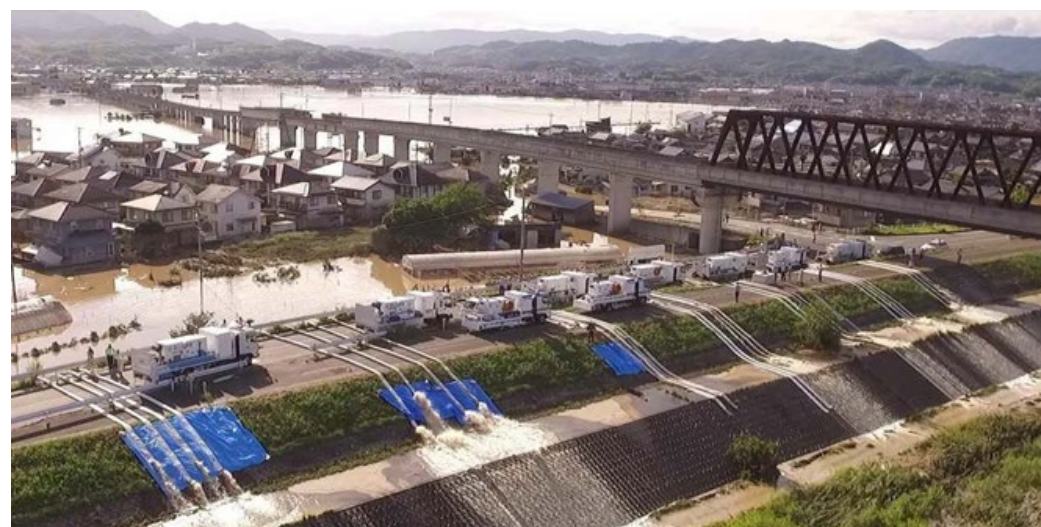
排水ポンプ車による排水支援状況（H30.7 岡山県倉敷市）
