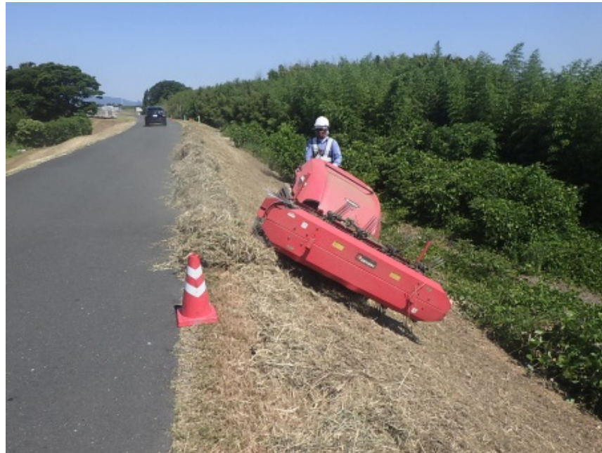
堤防除草の状況
