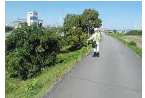
河川堤防点検の状況
