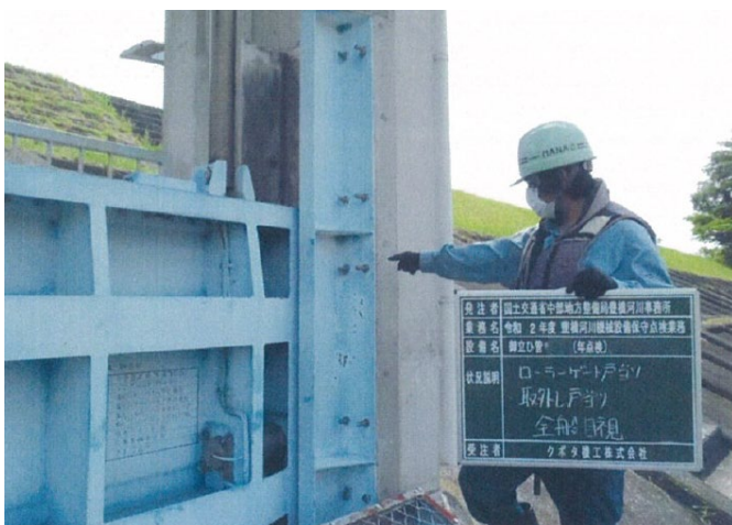
ゲート設備の点検
