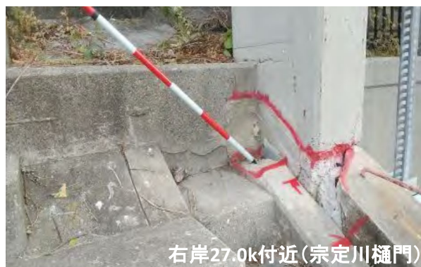
樋門部における取付護岸の損傷
