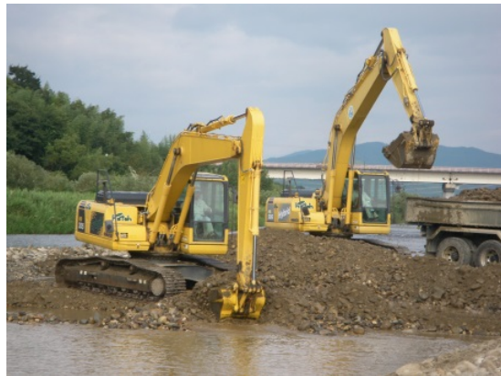
河道掘削の状況
