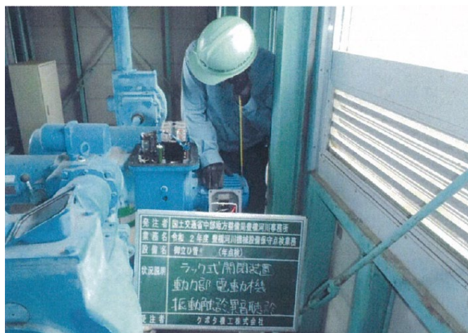
ゲート設備の点検
