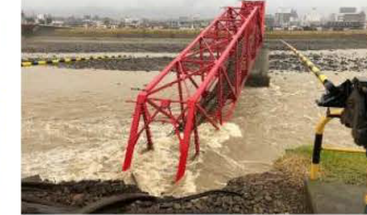
上田電鉄別所線 (千曲川橋梁)
