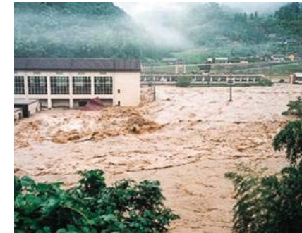
流失した幼稚園(豊田市(旧旭町))
