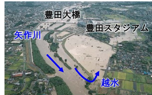
豊田市街地付近の越水氾濫状況
