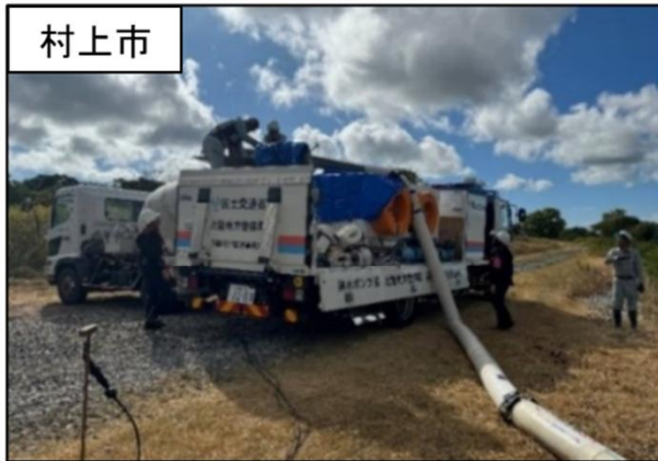
河川水のかみ上げ状況(排水ポンプ車)
