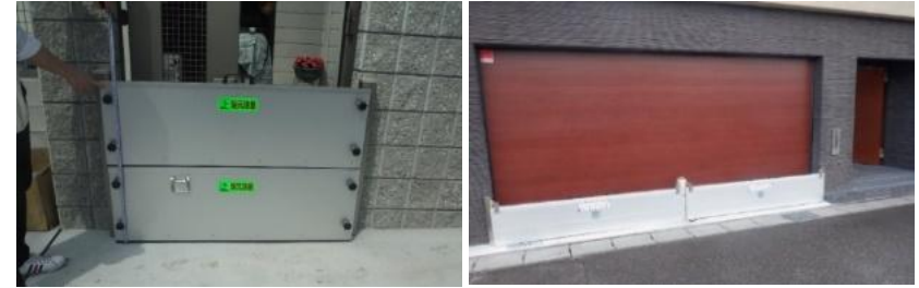
■ 止水板設置状況(対策事例)
