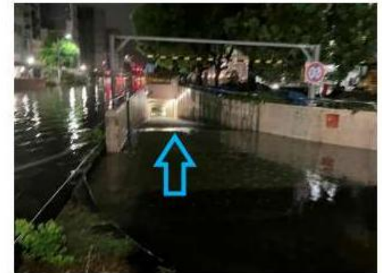
地上の冠水状況(9/13 0時頃)
