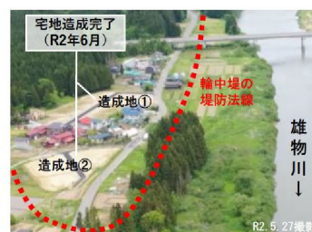
移転先宅地造成完了状況
