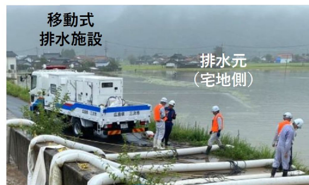
樋管のゲートにポンプを設置
