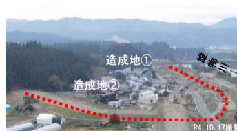
移転家屋の建設が進む状況
