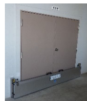
■荻原ポンプ場耐水化
