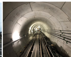
■工事中の八帖北幹線
