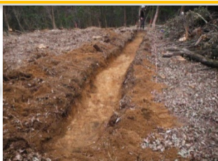
【⑤筋掘り完了後】
