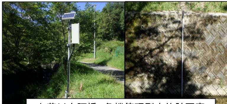
丸草川大阿橋 危機管理型水位計写真
