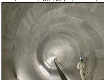
雨水貯留管内部 (仕上がり内径φ5,250mm)
