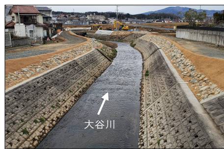
広島県による支川の改修
