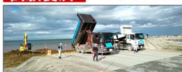
養浜材の荷下・投入状況 (R4.8.18 撮影)
