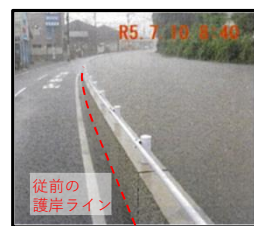
＜池町川護岸嵩上げ＞
