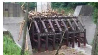
例:透過型砂防堰堤による流木の捕捉
