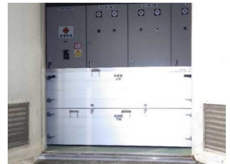
止水板による受変電設備への浸水対策
