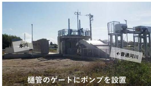
樋管のゲートにポンプを設置
