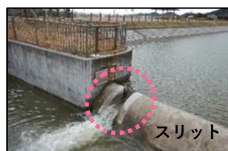
▲スリットの設置状況
