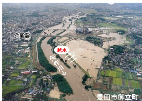
H12洪水/矢作川（豊田市）の越水状況
