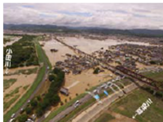
②小田川における浸水被害 （岡山県倉敷市）
