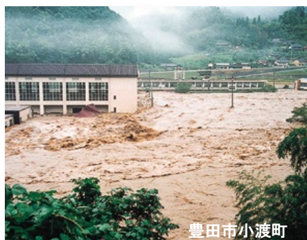
H12洪水/矢作川（豊田市）の洪水状況
