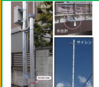
浸水センサー等による情報配信 (岡崎市)
