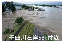
千曲川左岸58k付近
