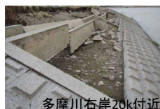
多摩川右岸20k付近
