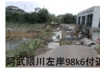
阿武隈川左岸98k6付近
