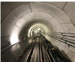
■工事中の八帖北幹線
