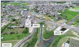
■安永川との合流点付近の様子
