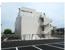
■六名雨水ポンプ場
