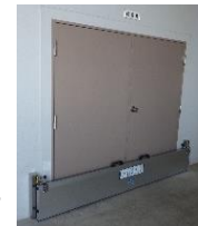
■荻原ポンプ場耐水化
