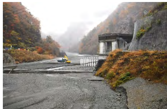
土砂バイパス 呑口
