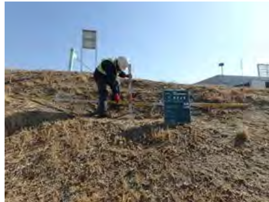
堤防点検の実施状況
