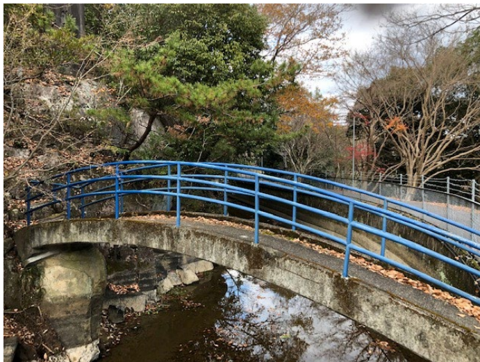
枝下用水の水路にかかる太鼓橋 水路は岩盤を掘削して作られている 橋を渡ると同資料室へ行くことができる
