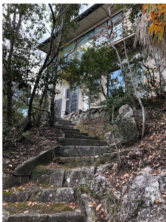
風情ある階段を上ると 豊田土地改良区資料室が現れる
