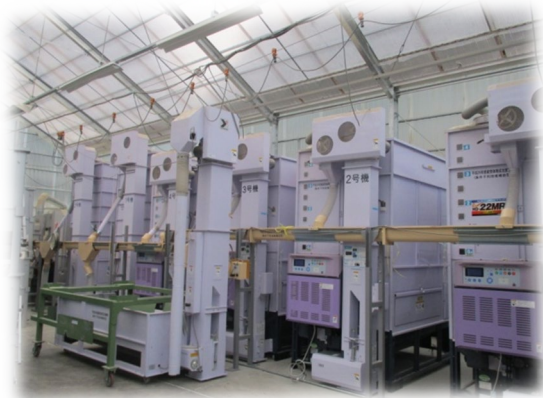
写真5 乾燥・糶摺り・袋詰め一貫プラント棟
