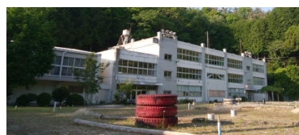
つくラッセル施設全景
