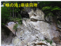
「喉の滝」崩壊箇所
