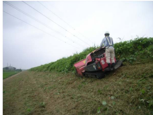
異常を早期発見するための 堤防除草
