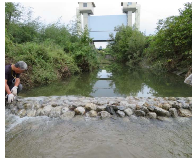
堰上げ式魚道施工状況
