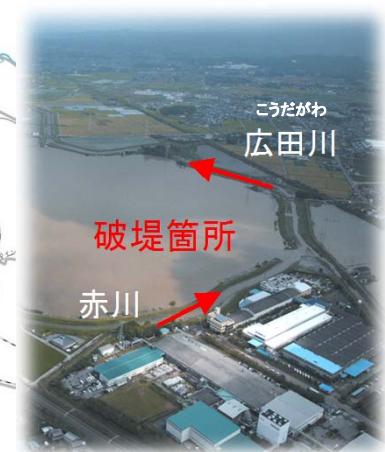
平成20年8月洪水 (広田川：左岸10km付近)
