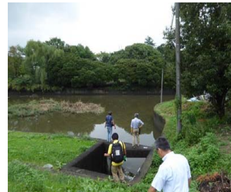
段差箇所の現地確認
