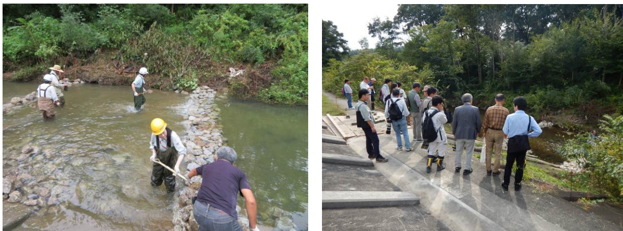
図 3 施工の様子（左写真）、第 35 回 WG 現地確認の様子（右写真）
