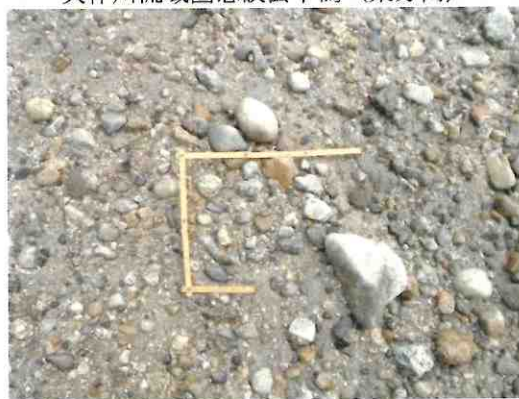
同上・表面の投入したダム砂
