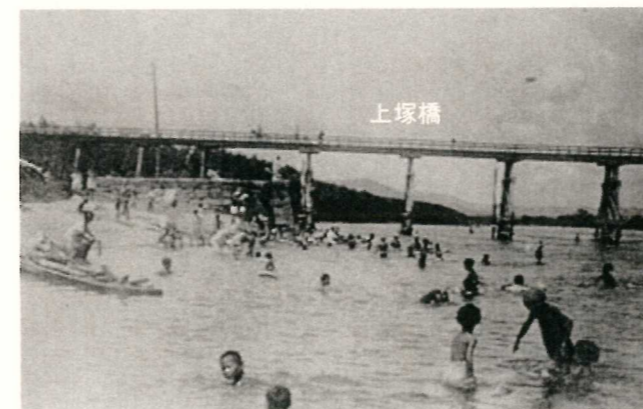
【昔の水浴の状況 (上塚橋: 7k 付近)】
