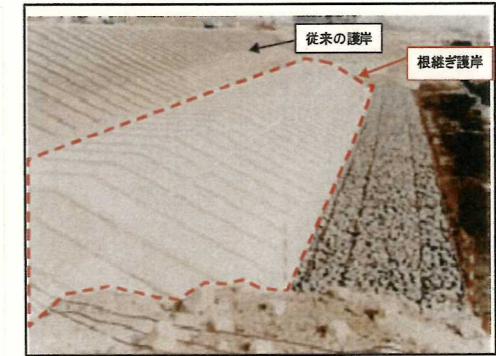
【護岸の根継ぎ状況】
