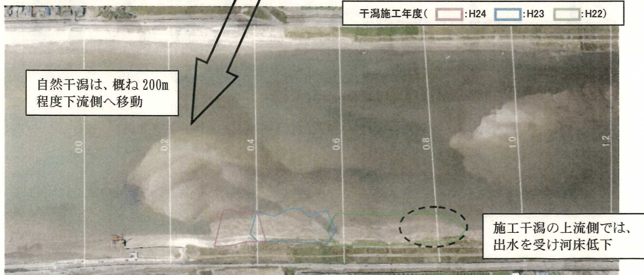
H26.10 撮影 ※干潮時（施工後4年目）
