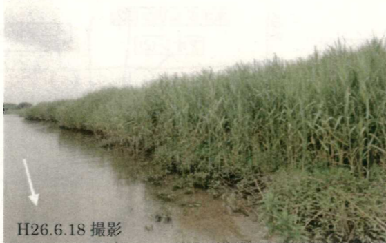
■ 5. 4k+00m 測線より上流側を望む
