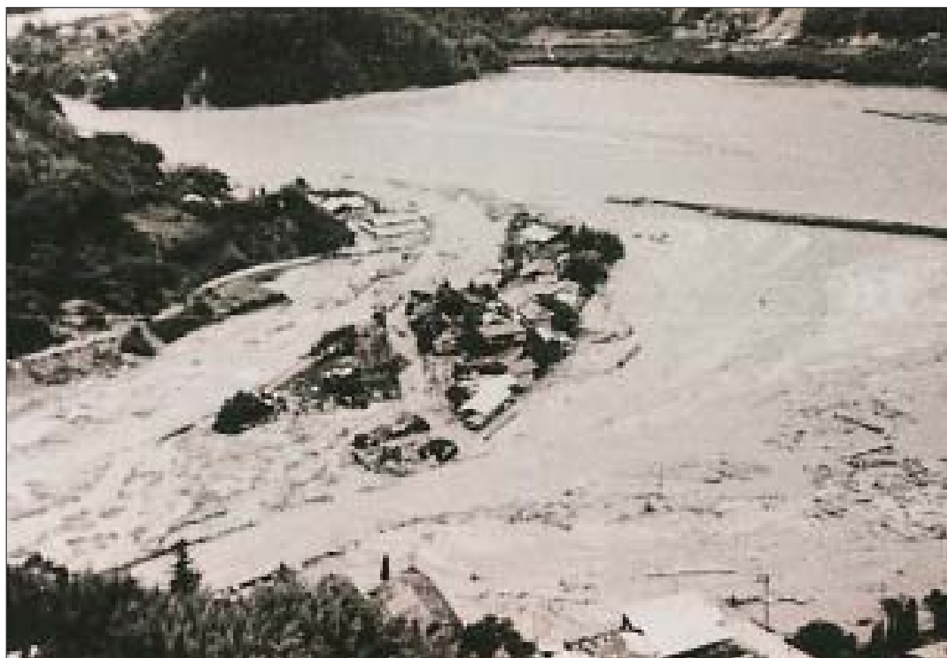
松川町 間沢川合流点付近 左岸から望む。
