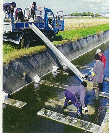
砂利を入れる作業。この段階では、あたりに生きものの気配は無い。
