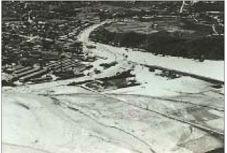
高森町 大島川合流点付近。 左岸から望む。
