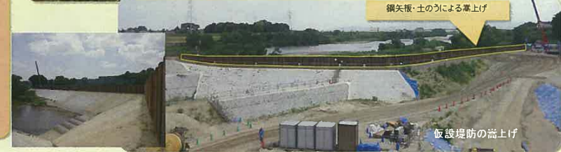
仮締切堤を鋼矢板・土のうで嵩上げ
