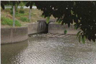
①家下川—承水溝の段差
