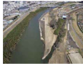
竣工時① 2012/3/20 (豊橋河川事務所)
