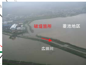
広田川流域の浸水状況(H20.8.29) (破堤箇所 赤川合流点 10k900 付近)
