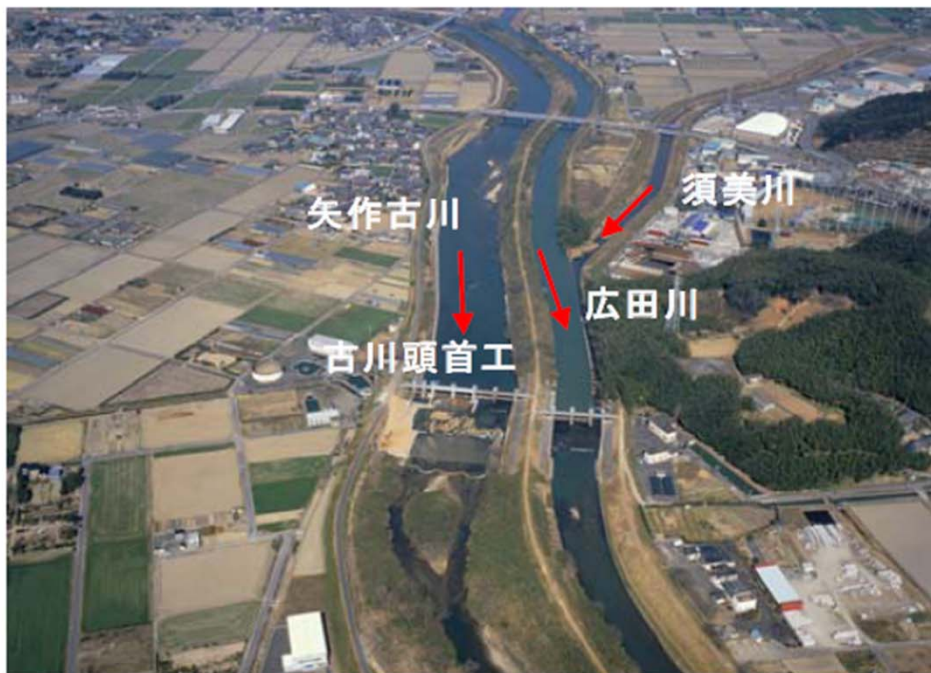
古川頭首工、吉良頭首工付近 (上流望む)
