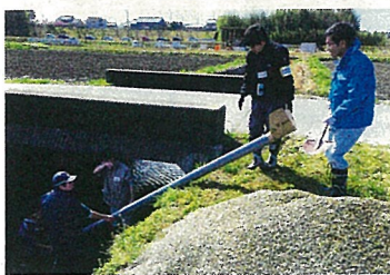
塩ビパイプが流れないように、重石としての砂をつめる。1チーム数人で、700mの間に5箇所を設置した。
