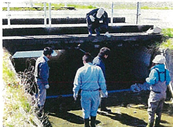
塩ビパイプはコンクリートの出っ張りに固定した。増水時に流されぬよう、数個の土嚢で重しをした。
