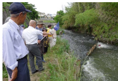
家下川合流点段差改善箇所の確認
