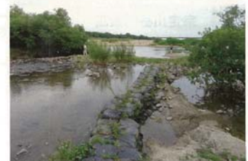
⑤矢作川本川合流部の導流堤設置カ所
