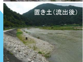
置き土による土砂供給 (矢作川)
