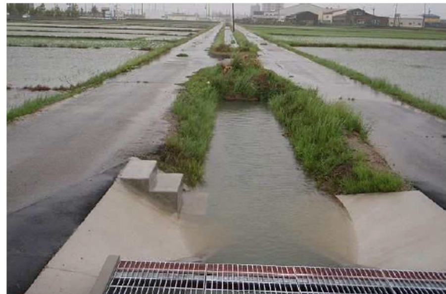
水路流量調整方式による水田貯留の様子（左：平常時、右：大雨時）
