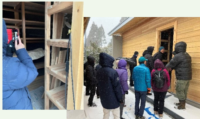
建設中の種倉庫
