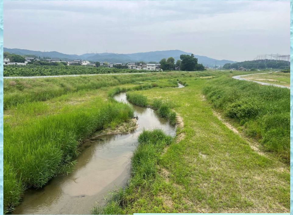
矢作川水系 籠川多自然川づくり
