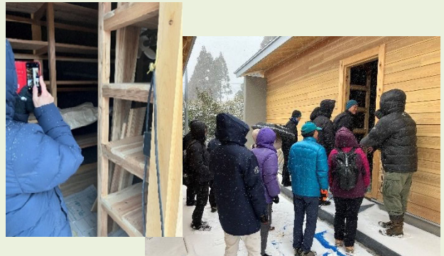
建築中の種倉庫
