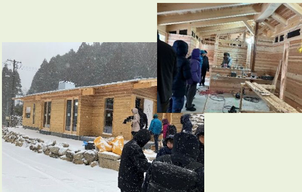
建築中の休憩所
