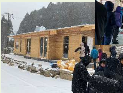
建築中の休憩所
