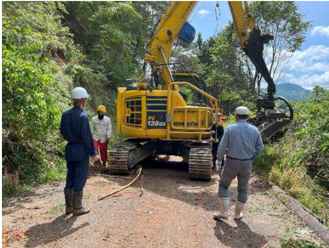
現場確認の様子
