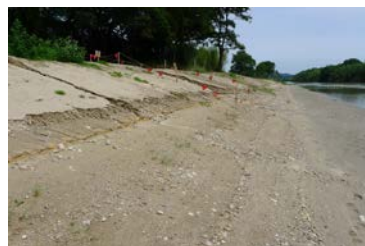
3割勾配の法面の状況
