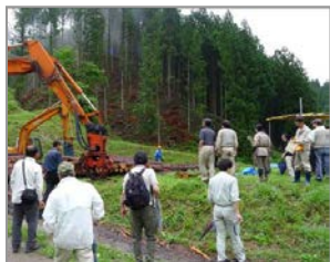
■ 松下薪材間伐作業現場
