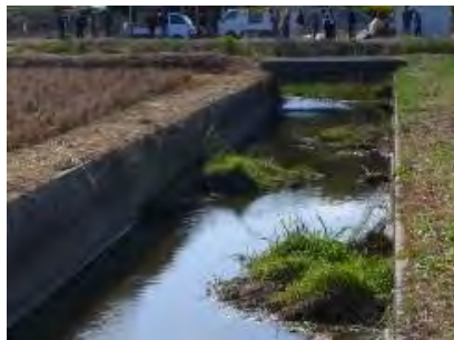
草の植え付け (中大排水路)
