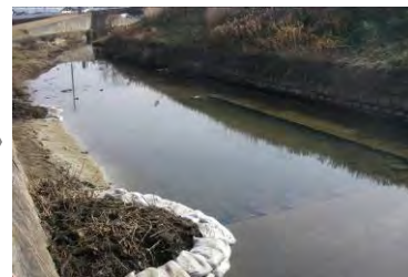
下流側に第2の越冬マス設置 (2013年1月に設置)
