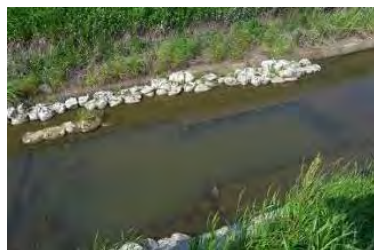
西大排水路に第1の越冬マス設置 (2011年に設置)
