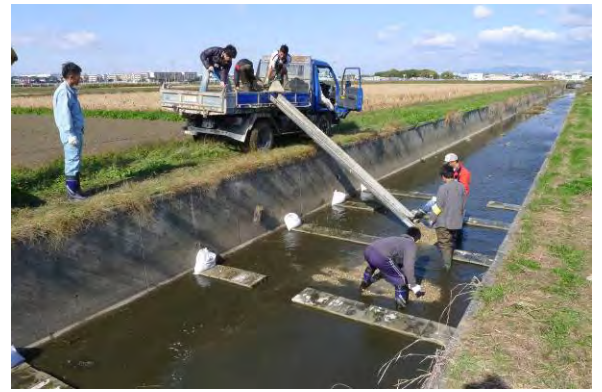
砂利を敷設状況 (家下川リバーキーパーズの活動)
