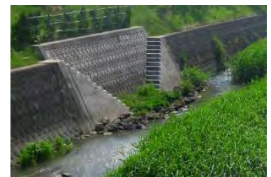
捨石による魚礁の設置
