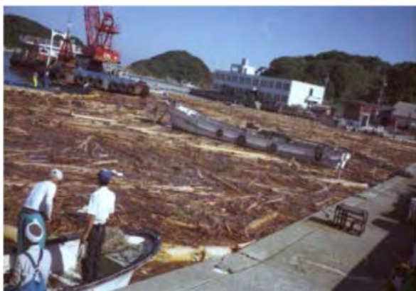
三重県答志島 桃取漁港（平成 16 年の台風後）
